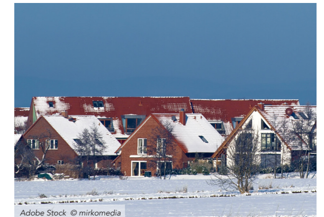
Wärmeverluste des Daches werden oft durch abschmelzenden Schnee sichtbar.
